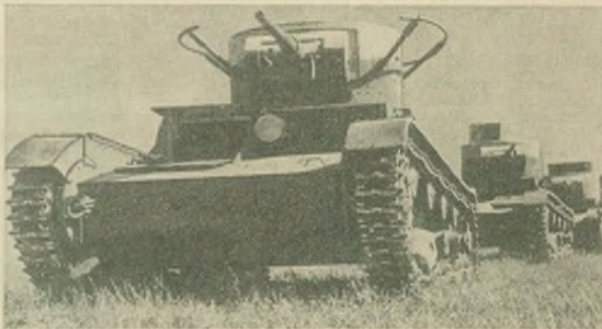
Sowjetische Panzer T-26 B von 1923. Vordergrund ein Kommandeurspanzer mit Funkantenne, die sich geländerartig auf dem Turm befindet
