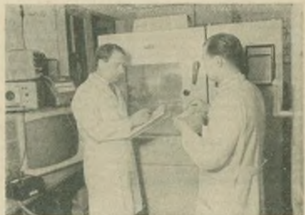
Bild 4: Besonders wichtig für den Export unserer Geräte ist die Überprüfung von Baugruppen und Geräten im Klimaklabor des ZRF
