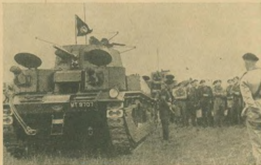
Führungspanzer mit Sende- und Empfangsanlage Ende der zwanziger Jahre. Die anderen Panzer führten nur Empfänger mit
