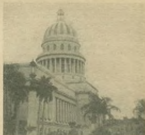
Das Capitolio in Havanna Foto: Verfasser
