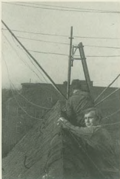
Bild 6: Die oberen Tragegängen werden am Herzstück befestigt
