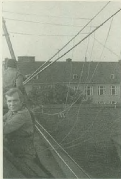
Bild 11: Die fertige Cubical-Quad, 1 m unter Gipfelhöhe
