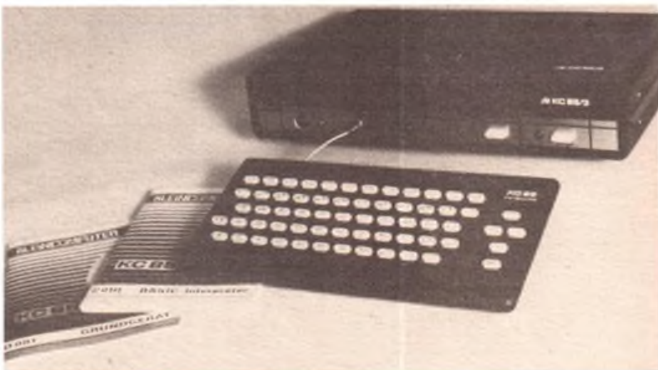
Eine Weiterentwicklung des bekannten Kleincomputers KC 85/2 ist der KC 85/3 mit integriertem BASIC-ROM (VEB Mikroelektronik „Wilhelm Pieck“ Mülhausen) Foto: RFT-Pressedienst
