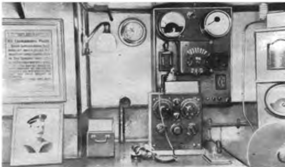
Die Funkstation der „Aurora“ wurde im Originalzustand rekonstruiert, rechts der Sender, Mitte Empfänger und Schalttafel, links Wellenmesser und Foto des Oberfunkers F. N. Alonzew. Unten QSL-Karte der DOSAAF zum Jubiläum
