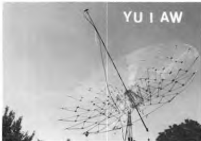
Dragos (YU1AW) 12-m-Spiegel, der in der Nähe von Belgrad steht. Zum Bandwechsel braucht nur der Primärstrahler am Kopf des Antennenträgers ausgewech-
