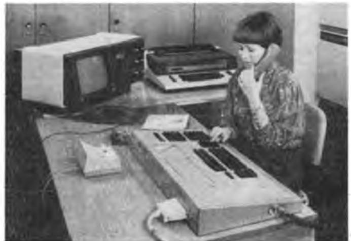
Die digitale Nebenstellenzentrale NZ 400 D/384 für 128 bis 384 Teilnehmerleitungen und max. 48 Hauptanschlußleitungen ist zur Digitalisierung von Betriebsnetzen vorgesehen. Mit zusätzlichen Einrichtungen wird sie zur Datenübertragungsstelle.
