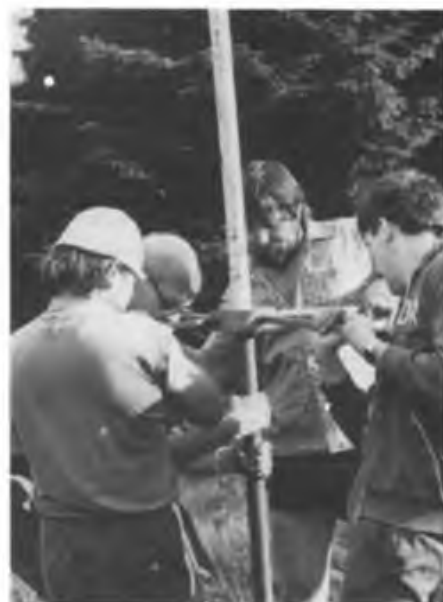
... das jetzt ein paar kräftige Männer anheben und solange halten müssen, bis ein Stück Stahl-Verlängerungsrohr eingesteckt ist.
