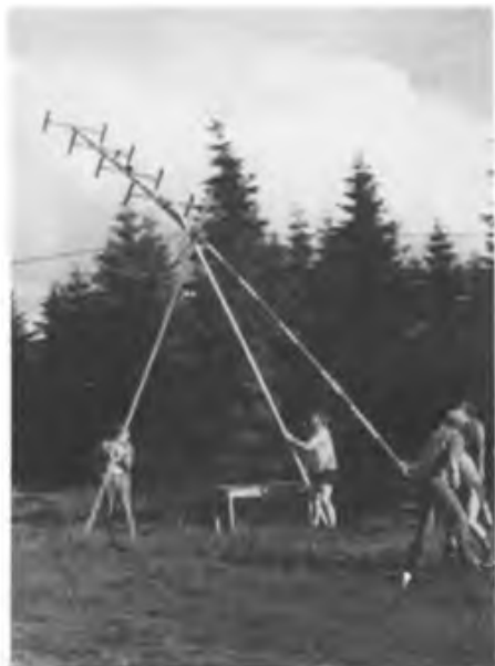
Der „Torso“ der Antenne gelangt auf herkömmliche Weise in die Senkrechte. Eine Hebegabel leistet dabei wertvolle Dienste.
