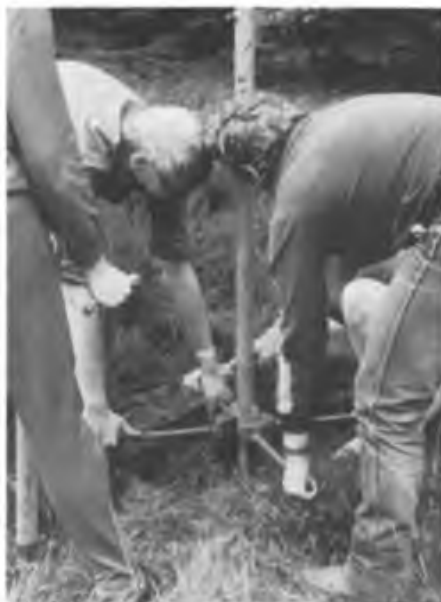
Danach wird ganz unten am Standrohr der Antennenkonstruktion ein speziell angefertigtes Hebekreuz stabil angeschraubt, ...
