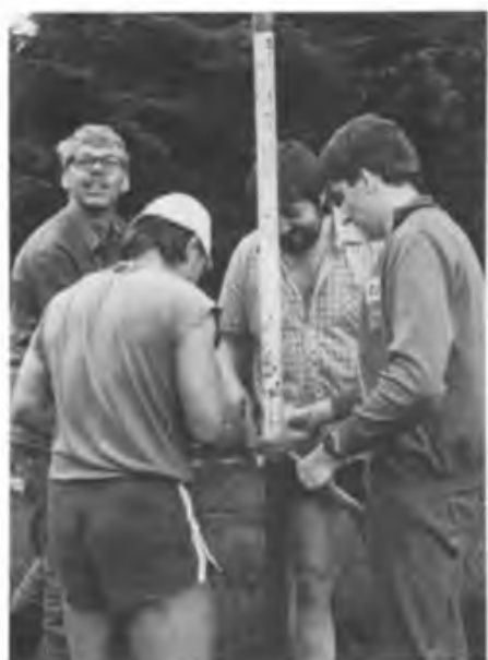
Nach dem Absenken des nun um reichlich einen Meter verlängerten Standrohres kann man das Kreuz geruhsam abschrauben, um die Prozedur so oft von vorn zu beginnen, bis die Höhe ausreicht.
