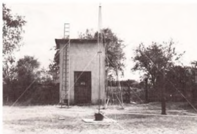
Bild 5: Dieses Bild vermittelt einen guten Eindruck davon, wie die mechanische Stabilität durch Verspannungen mittels Plast-Leinen entsteht. Fotos: Y21RD
