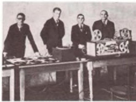
Bild 4: Mitschnitt einer Ansprache im Kabelwerk Oberspreewald im November 1933. Das Tonbandgerät ist noch ein Labormuster. E. Schüller – leger an der Wand lehnd – bekam am 24. 12. 1933 den Ringkopf patentiert.
