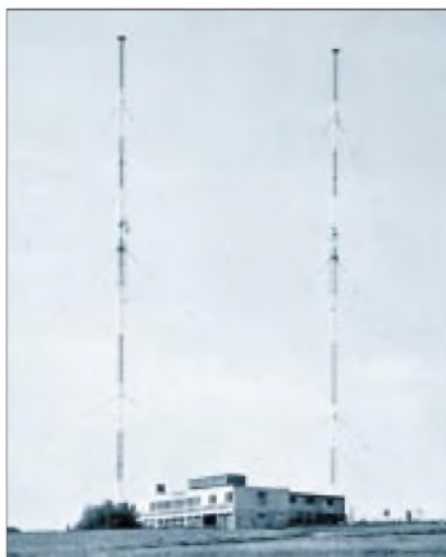
Sendetürme des Mittelwellen-Großsenders der Europawelle Saar Heusweiler, der tagsüber mit 1200 kW, nachts mit 600 kW sendete Foto: Europawelle Saar
