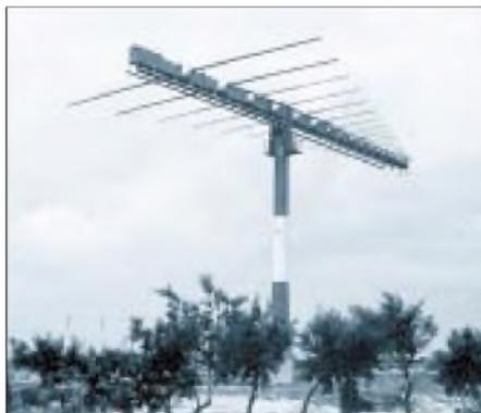
**Bild 1: Logarithmisch-periodische Antenne der DW Malta**
