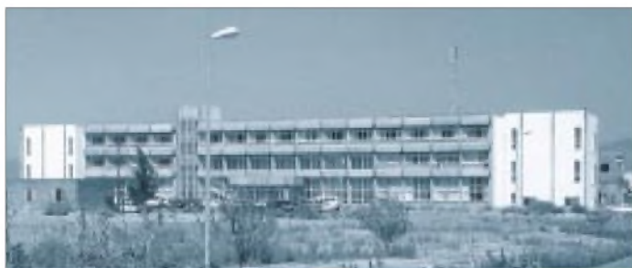
Das neue Funkhaus von Radio Bayrak
