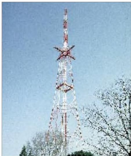
Antennenmast des Mittelwellensenders der RAI in Udine/Italien
