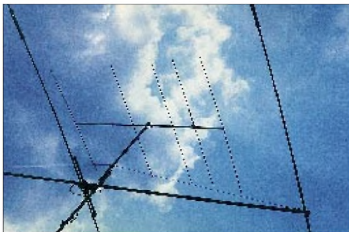
Bild 8: Die beschriebene Antenne auf dem Dach
