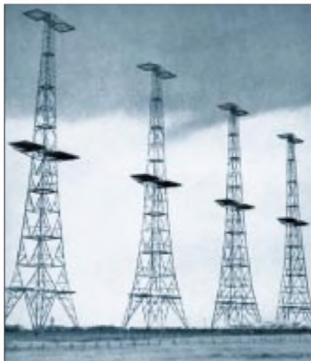
An achtzehn Stellen der englischen Küste standen zu Beginn des 2. Weltkrieges diese mehr als 80 m hohen Türme der „Chain Home“, der ersten Radarkette auf 12-m-Wellen.
