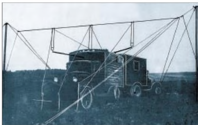
Erste sowjetische Funkmeßstation RUS-1 (Empfangsanlage) aus dem Jahr 1939.
