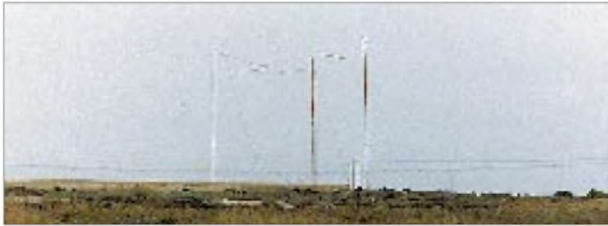
Eine Reihe kleinerer Rundstrahlantennen versorgte Südeuropa mit Programmen der Deutschen Welle.
