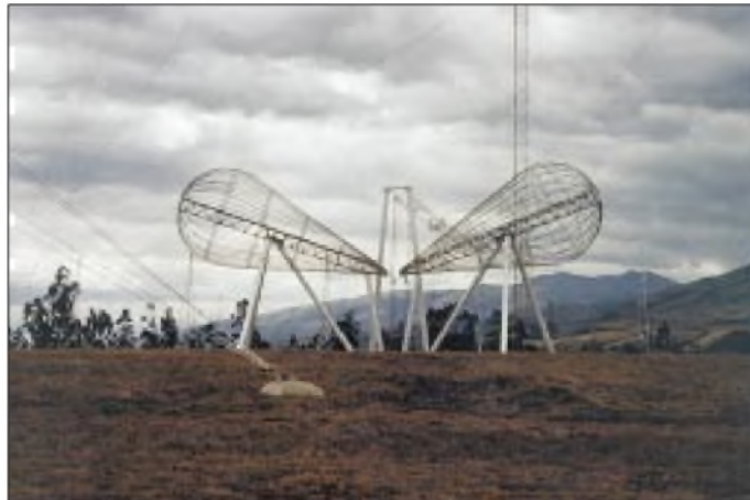
Auf Schienen kann diese Antenne in die gewünschte Richtung gedreht werden, um die bis zu 500 kW Sendeleistung abzustrahlen.
