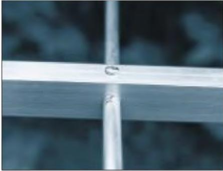
**Bild 16: Befestigung der Elemente im Tragerohr 20 mm x 20 mm**
