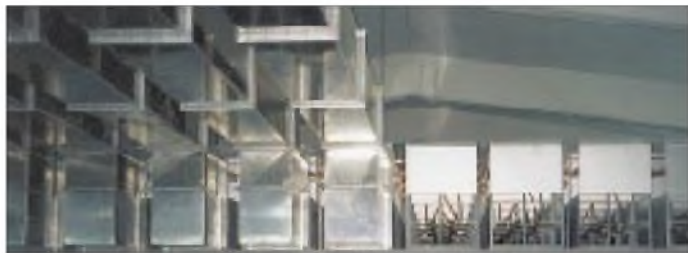
Teil des Kühlsystems eines 500-kW-Senders
