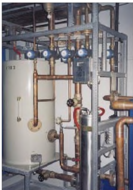
Teil des Kühlsystems eines 500-kW-Senders
