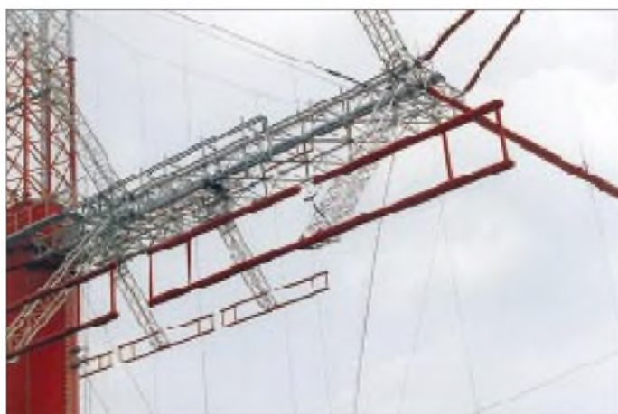
Der Antennenfuß – an den Straßenlampen werden die Größenverhältnisse deutlich. Rechts vom Mast ist die unterste Dipolzeile für die höherfrequenten Bänder zu erkennen.
