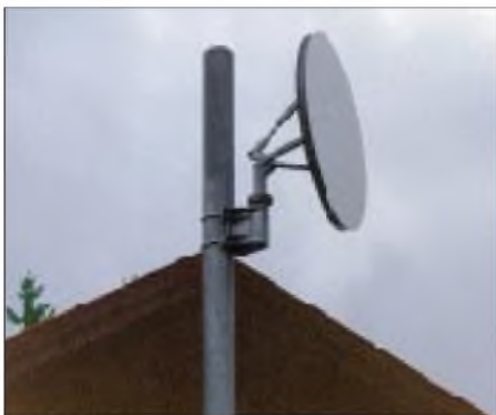
Auch das gibt's: Passiver Umlenkspiegel für eine Richtfunkstrecke
