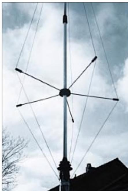
**Bild 7:** Die Seitendrähte sind beweglich geführt.
