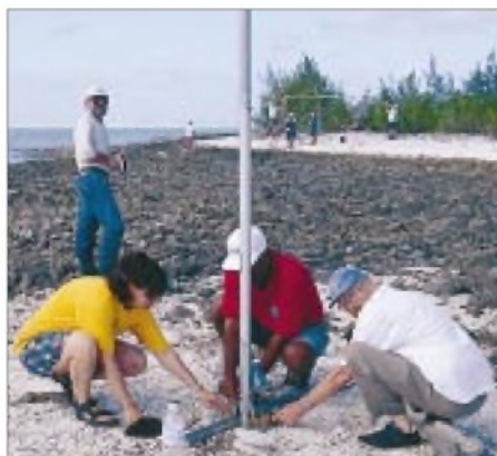
Christine, Urs, Jacky und Hugo befestigen die Radialdrähte an der Battie Creek Spezial.
