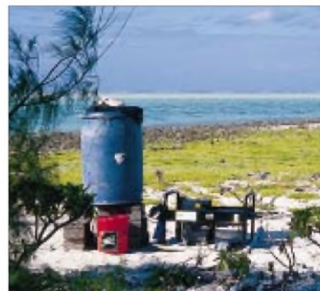
Der Generator. Das blaue Faß ersetzte den Tank, was einen unterbreuchsfreien Betrieb von 11 Tagen ermöglichte.
