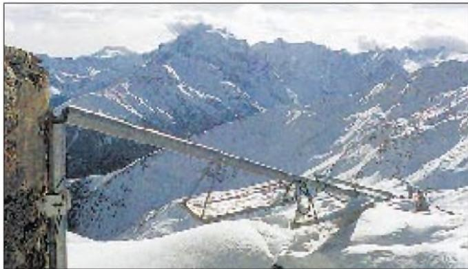
**Die Wurzel allen Übels: der geknickte Mast. Daneben die freigeschaufelten Solarpaneele**
