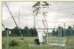
Geerdeter Mastfuß des 325 m hohen Antennenträgers für die Rhombus-Antenne; die sechs Strahlerelemente werden unmittelbar über den Isolatoren eingespeist. Foto: DL6AKC
