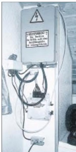
Bild 4: Fernbedienter Tuner mit Schaltbox und Potentialausgleichsschiene, auf der alle Radials enden
