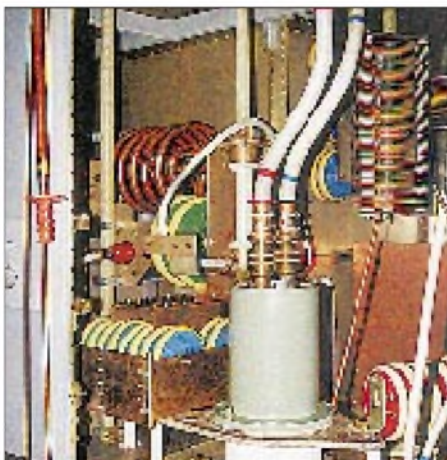
Wassergekühlte Endstufenröhre des Mittelwellensenders Sölvesborg ▲
