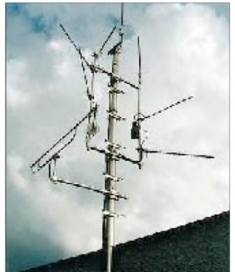
OE9XPR auf dem Dach der Pfänderbahn-Bergstation: für jede Datenfunkstrecke wurde eine eigene Richtantenne montiert. Foto via OE6GLD
