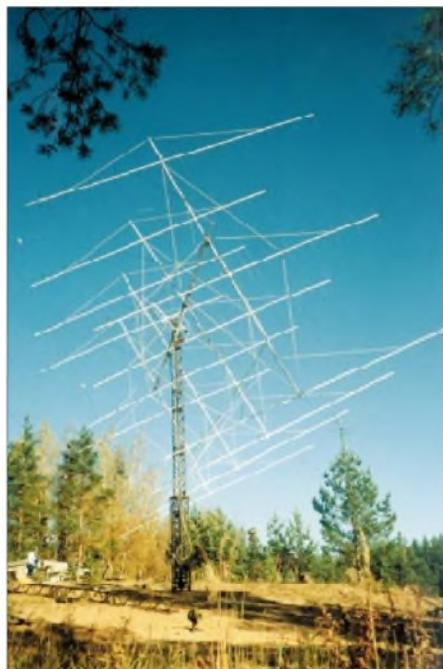
Die Antennen von RU1A in KO48VR: 12 x 14-Ele. horizontal und 12 x 10-Ele. vertikal. Foto via DK3WG
