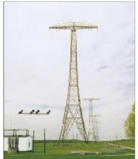
**Das Antennensystem wird von sechs Gittermasten getragen, vorn links die Einspeisung und die Abstimmspule für den vorderen Vertikalstrahler.**
