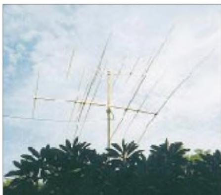
Die Yagis bei TL5A (Force 12C4 für 10 bis 40 m und 5-Element-Tonna für 6 m) auf dem 12-m-Mast, der sich in TL8GRs Garage fand.
