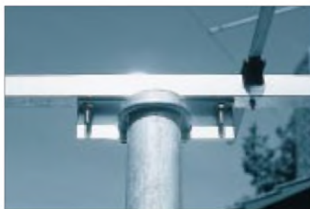
Bild 6: Selbstgebaute Halterung für Yagi-Antennen
