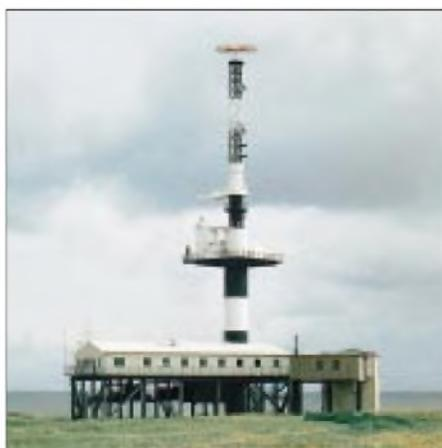
Radarstation Minsener Oog mit dem Querkennzeichen „Bühne C“. Zum Schutz gegen Sturmfluten stehen die Betriebsgebäude zwei Stockwerke über dem Wasserspiegel.
