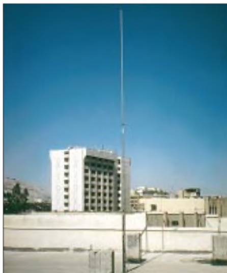
Die knapp 6 m hohe Groundplane der TIR-Klubstation, die bei YK/DL6MHW zum Einsatz kam
