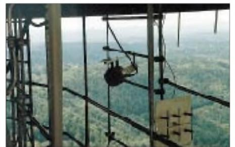
Linkantennen von DB0AAC zu DB0GE (Scheibenantenne) und DB0KLN (Flächenantenne).
