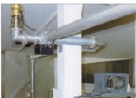
**Bild 7:** Umschalter für Antenne/Konstantantenne, unten rechts der Kompressor für die permanente Trockenluft-Spülung der Koaxialleitung
