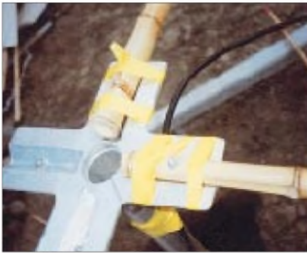
Bild 3: Aluminiumkreuzstücke [3] mit Befestigung der Bambusrohre Fotos: DL7VEE
