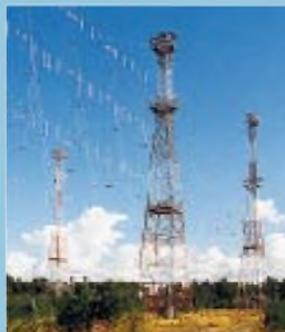
Selbsttragende Masten mit imposanten Vorhangantennen strahlen in der Nähe der südwestfinnischen Stadt Pori die Kurzwellenprogramme von Radio Finnland, YLE, ab. Insgesamt stehen dazu fünf Sender zur Verfügung, drei mit je 500 kW, einer mit 250 und einer mit 100 kW Trägerleistung. Mehr dazu ab Seite 738.
