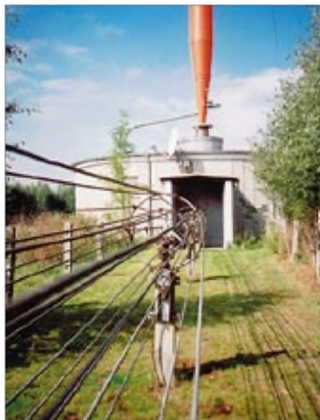
Koaxialleitung einmal anders ... Im Hintergrund der Fuß des auf einem Isolator lastenden 110-t-Mastes
