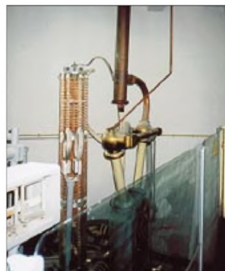
Erdschalter, Speiseleitung und Spannungsverdrosselung für die Flugsicherungsbeheizung am Fuß des Sendemastes
