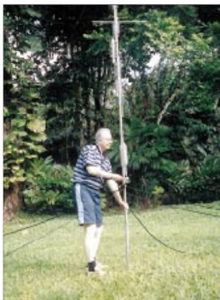
Aufbau der Butternut-Vertikalantenne
