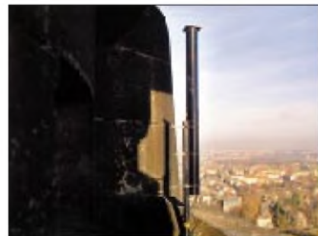
Die Antennen für die 70/23/13-cm-Baken sind in einem PVC-Rohr wasserdicht untergebracht (nach der bewährten Bauweise von Karl Weiner, DJ9HO, nachzulesen in seinen „UHF-Unterlagen“).
