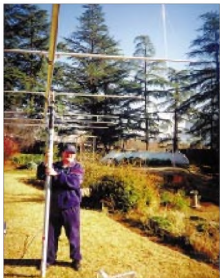
Thomas, DJ6OI, beim Aufbau einer 6-Ele.-ZX-Yagi am Standort von 7P8AA im Juli 2000. Trotz 1 kW und Skeds gelang kein QSO auf 6 m.
