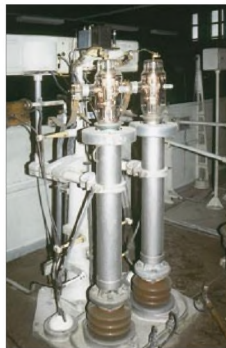
Die beiden Röhren der Gegentaktendstufe des 250-kW-MW-Senders in Burg bei Magdeburg, vgl. a. [6] Fotos: G. Klawitter (3)
