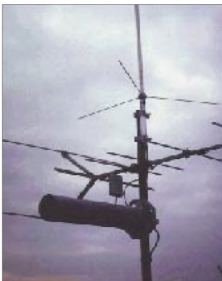
Antennenanlage von DB0WTS in Wattenscheid.
