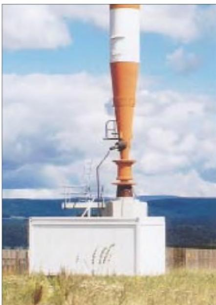
Container mit Antennenanpassung der direkt gespeisten Vertikalantenne
