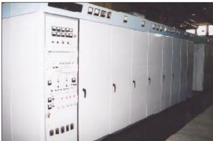
Der Sender PSW 1000 besteht aus zwei baugleichen 500-kW-Blöcken in Form solcher „Schränkände“
