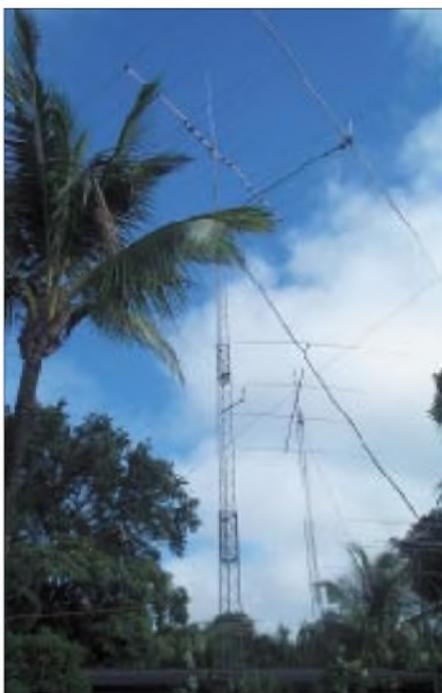
Günters imposante Antennenanlage. Im Vordergrund der 23 m hohe Mast mit der 11-Ele.-Force-12 für 20 bis 10 m und 2-Ele-80-m Yagi. Im Hintergrund die 4-Ele.-KLM-40-m-Yagi auf einem 20 m hohen Mast.
