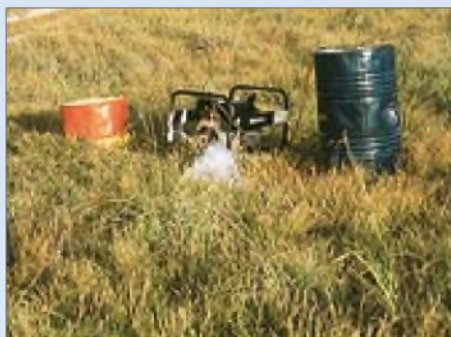
Die 5,5-kVA-Dieselaggregate waren abseits aufgestellt und liefen die ganze Zeit durch
