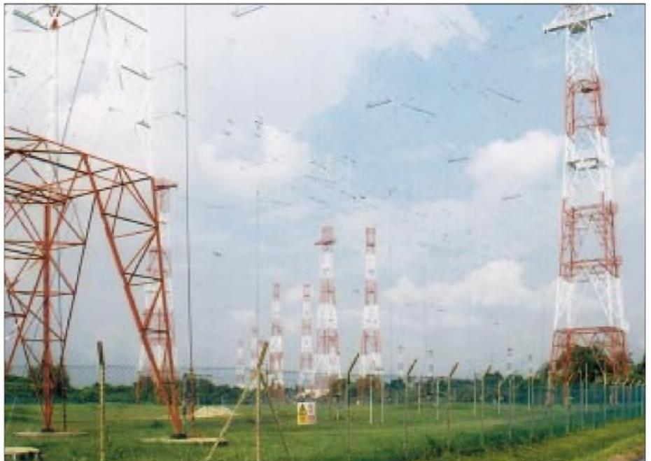
Vorhangantennen auf dem Gelände der Relaisstation
