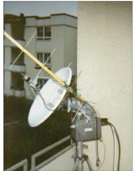
Bild 2: Antennenanlage auf dem Balkon
