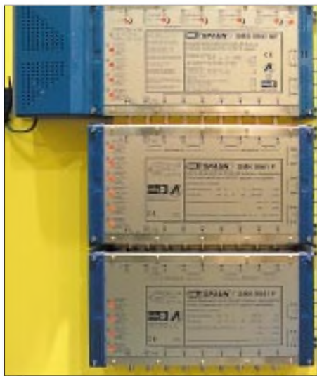
Bild 1: Kaskadierbares, DiSEqC-fähiges Multischaltersystem SMK 99xx von Spaun zur Verteilung von acht Satellitenebenen zuzüglich terrestrischem TV/UKW-Signal
