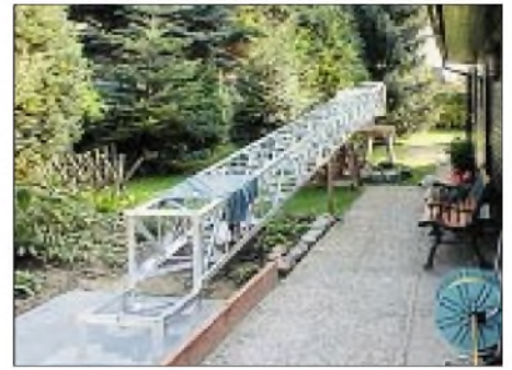
Bild 7: Zum Aufrichten des 120 kg schweren Mastes bedarf es unbedingt mehrerer Helfer.
