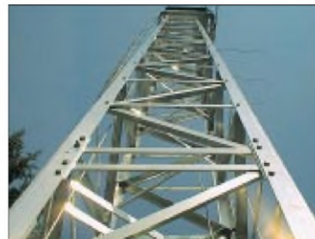
Bild 9: Am Ziel – der zusammengeschraubte Gittermast ist aufgerichtet. Fotos: DC7KM
