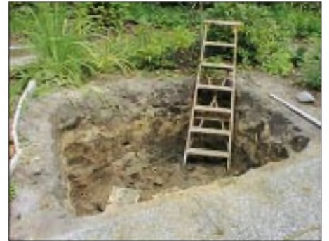
Bild 2: Den Ausgangspunkt bildet das Ausschachten der Grube – 4 m 3 Erdrreich!
