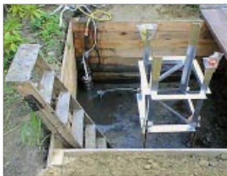
Bild 4: Der ausgerichtete und verankerte Mastfuß
