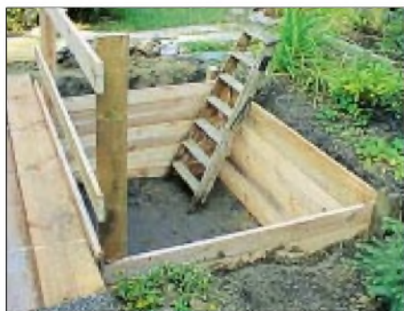
Bild 3: Schalbretter verhindern das Einstürzen der Grubenwände.
