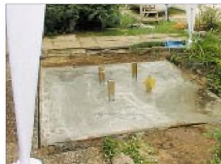
Bild 5: Das fertig gegossene Fundament ist einige Tage feuchtzuhalten und vor praller Sonne zu schützen – hier mittels Partyzelt.
