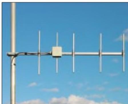
**Bild 5:** Vormastmontage bei der 5-Element-Yagi
