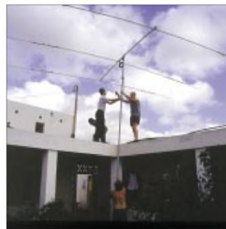
Abbau der Antennen am 14.3.
